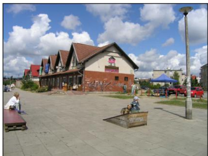
FOT. 3 Widok wzdłuż deptaku na zabudowę handlowo-usługową
