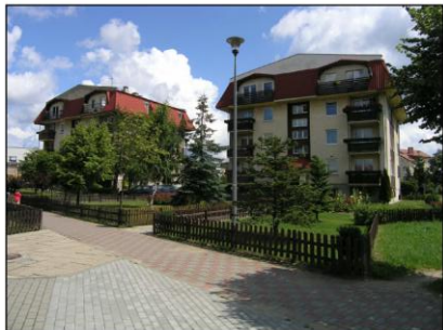
FOT. 1 Widok zmodernizowanych budynków wielorodzinnych
